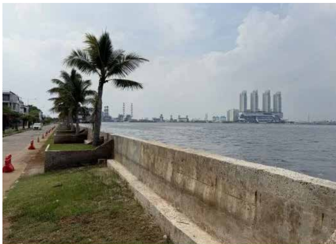
▲지난달 26일 대방조제가 들어설 자카르타 북부 해안가 마을 일대 모습. 바닷물이 넘어오지 않도록 해안이 도로를 따라 둑이 길게 설치돼 있다.
