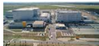
▲에코프로비엠 헝가리 공장 전경(에코프로그룹 제공)/뉴스1
