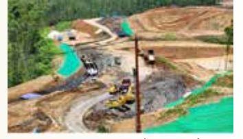
▲인도네시아 신수도 '누산타라' 건설 현장 [연합뉴스]
