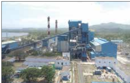
아우람 화력발전소 (보유지분98%, EPC수행)
