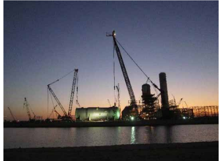
▲해외건설 아랍에미리트(UAE) 아부다비의 루와이스 석유화학단지 건설현장. GS건설이 길이 61m, 무게 1860t짜리 리제너레이터(족매 재생기)를 설치하고 있다. /조선DB
